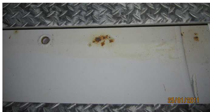
Puntos de corrosión reparables en la sentina
